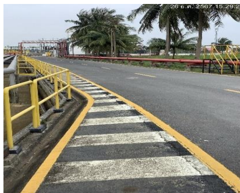
ภาพที่ 2-2 รางระบายน้ำคอนกรีตภายในคลัง
