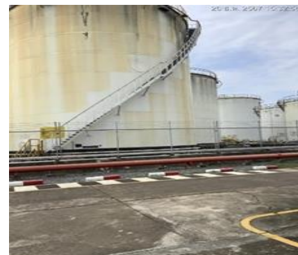
ภาพที่ 2-5 คันคอนกรีตสูง 1.00 เมตร ล้อมรอบลานถังเก็บน้ำมัน
