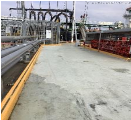
ภาพที่ 2-7 คั่นคอนกรีตสูง 0.10 เมตร บริเวณหน้าท่า
