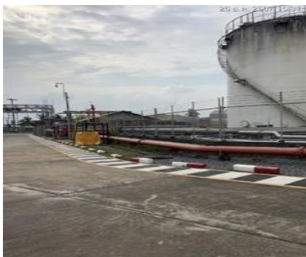
ภาพที่ 2-5 คันคอนกรีตสูง 1.00 เมตร ล้อมรอบลานถังเก็บน้ำมัน
