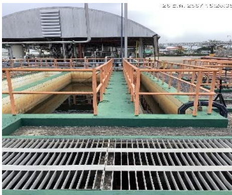
ภาพที่ 2-3 บ่อดักตะกอน (Collection pond)
