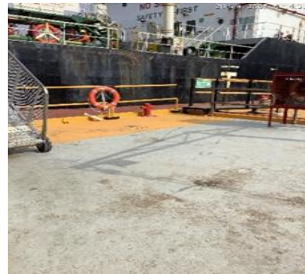
ภาพที่ 2-7 คั่นคอนกรีตสูง 0.10 เมตร บริเวณหน้าท่า
